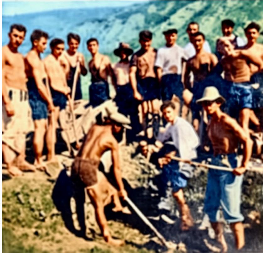
Valea Chintăului – Cluj: legionarii lucrează la scosul pământului frământat pentru confecționarea cărămizilor în vederea construirii căminului „Ardealul Legionar”.
