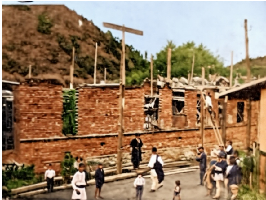
Se lucrează la construirea unui Cămin Cultural (satul Laz, județul Alba). Conducerea taberei: Dr. în Drept: Ilie Colhon.
