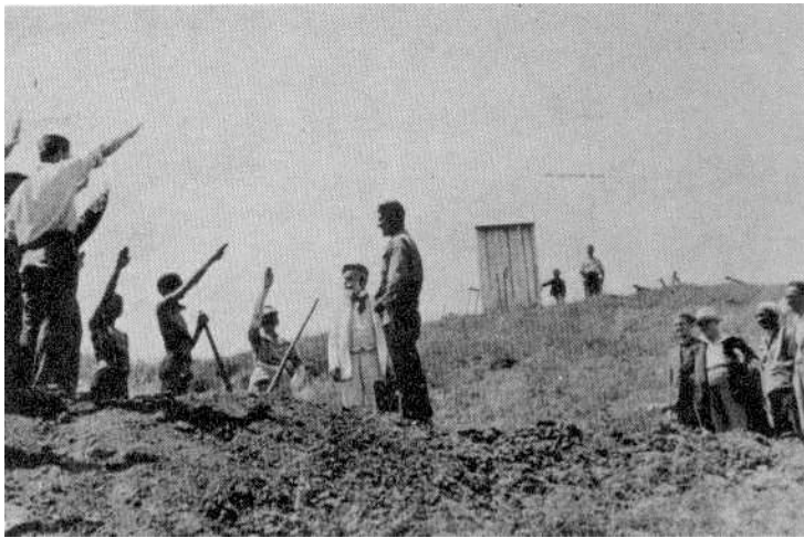
33. Generalul Cantacuzino inspectează lucrările
