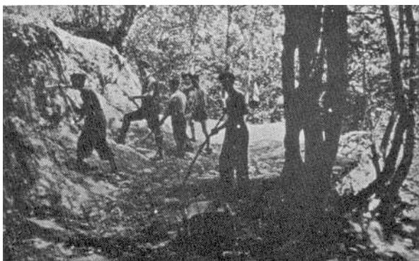
51. Tabăra Arnota unde se construia un drum spre Mânăstirea Arnota
