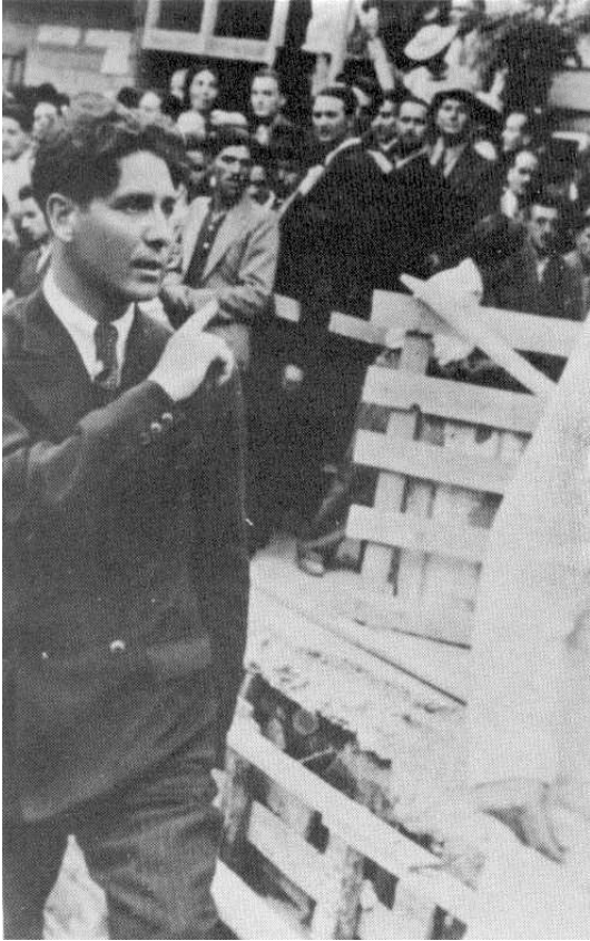
55. Căpitanul pe șantierul de lucru la sediului din Gutenberg
