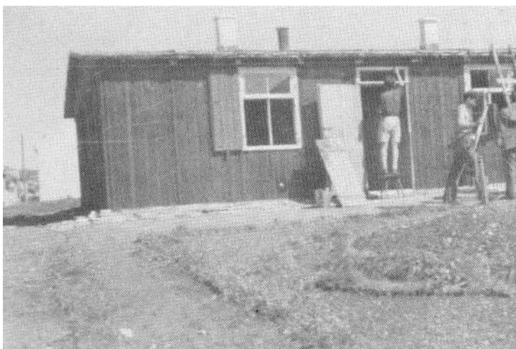
11. Voluntari ai Comitetului Român din Salzburg la lucrări de reparație și de amenajare ale barăcii
