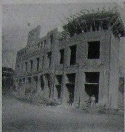
Căminul în construcție.
