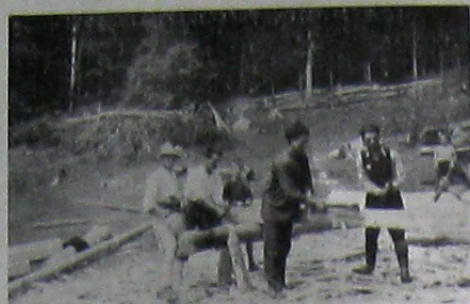
Trunchiurile de brazi se preschimbă în bărne pentru casă.
