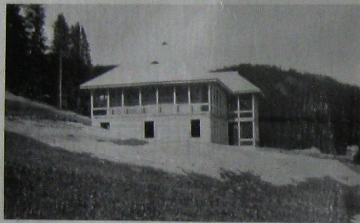
Casa văzută dintr'o parte. Casa are o lungime de 26 metri și o înălțime de 16 metri.
