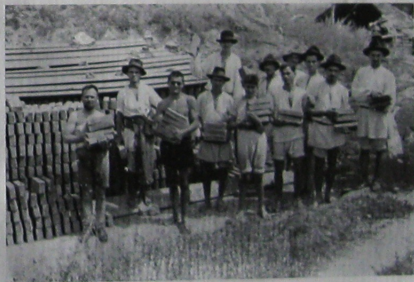
Cărămizile pleacă spre cuptor.
