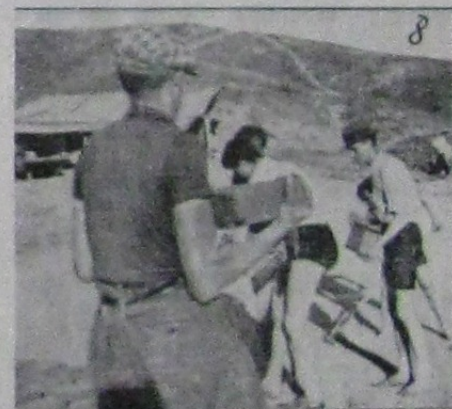
Cărămizile sunt răstornate din formă pe arie. 81
