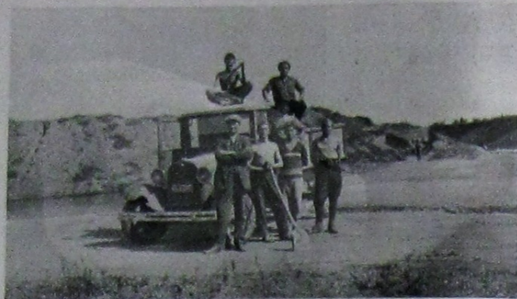
Camioneta „Oltenia” transportă cărămizile de la cărămidărie la Casa Verde.
