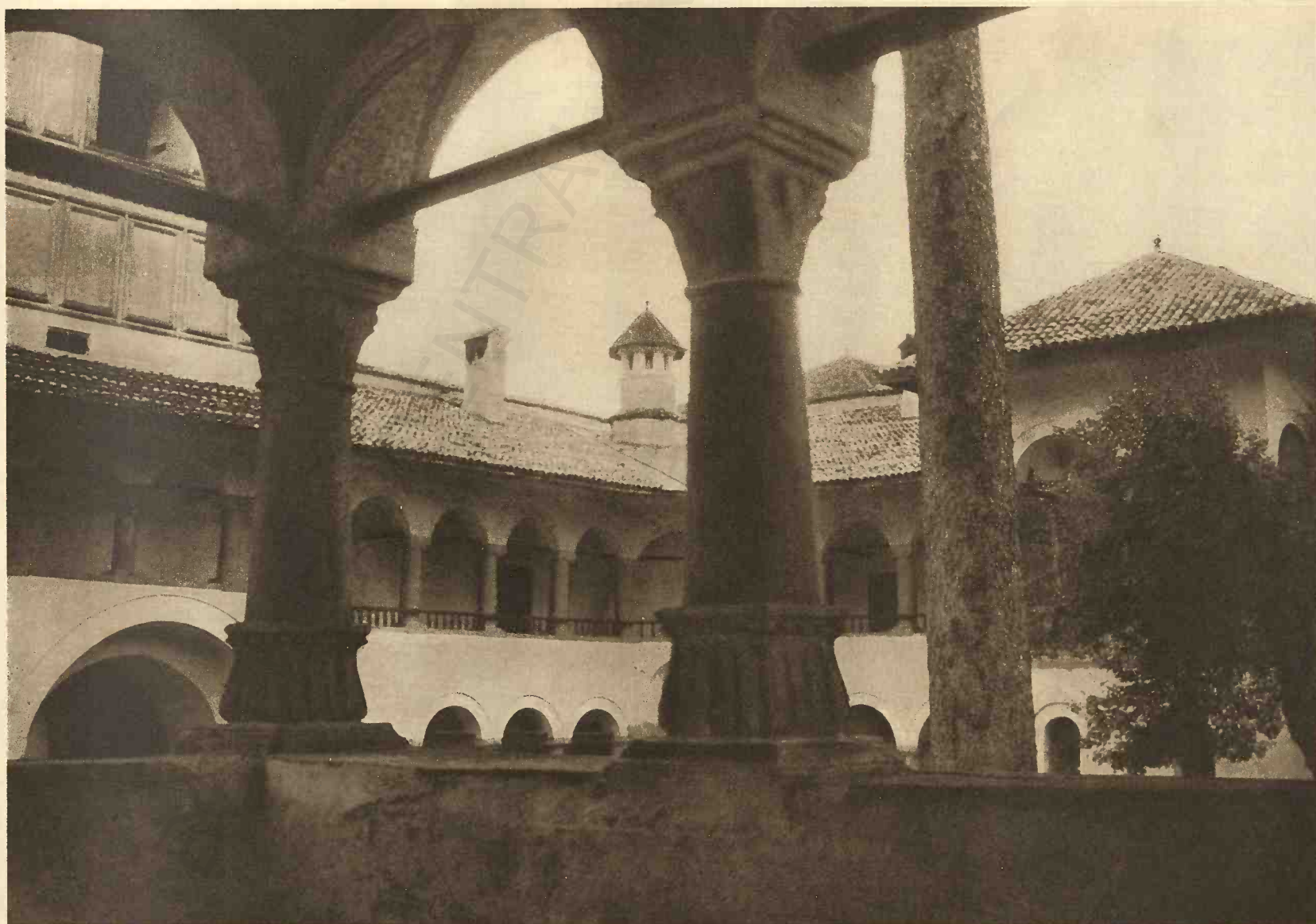
La cour intérieure avec ses deux étages de galeries.
