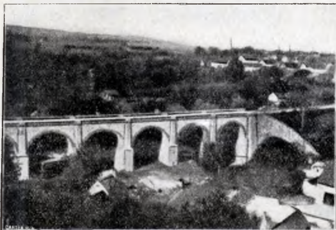
Fig. 3.—Viaductul dela Oravița de pe linia ce duce la Anina (d. I. Pășărică).
