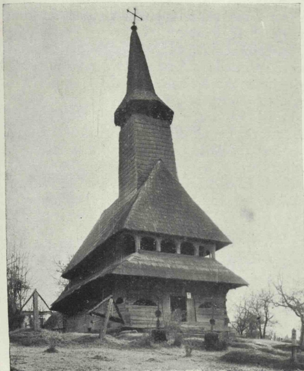
Fig. 231. — Biserica din Rona-de-Jos. Vedere din față.
