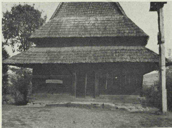
Fig. 242. — Biserica din Apșa-de-Jos. Fațada.
