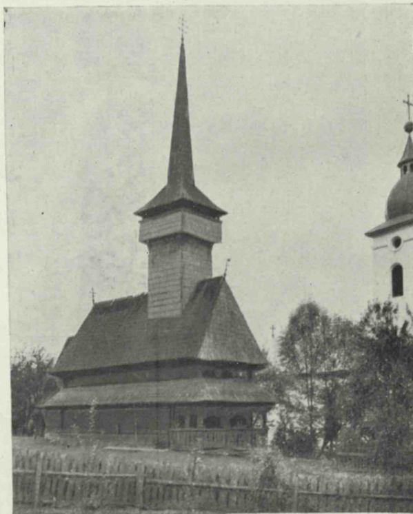
Fig. 228. — Biserica din Borșa. Vedere din spre Nord-Vest.
