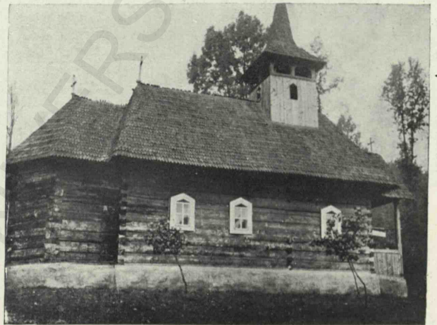
Fig. 237. — Biserica cea nouă din Valea Porcului. Vedere din spre Nord.
