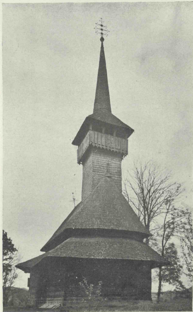
Fig. 81. — Biserica din Călinești. Vedere din față.
