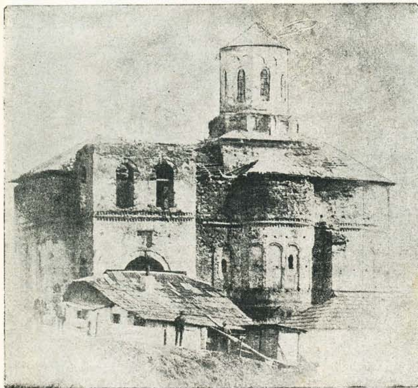
105. Prima Mitropolie a Moldovei, azi Bis. Mirăuți, (înainte de restaurare, lângă Suceava, zidită de Alex. c. Bun, refăcută de Ștefan c. M. (CMI Bals).
