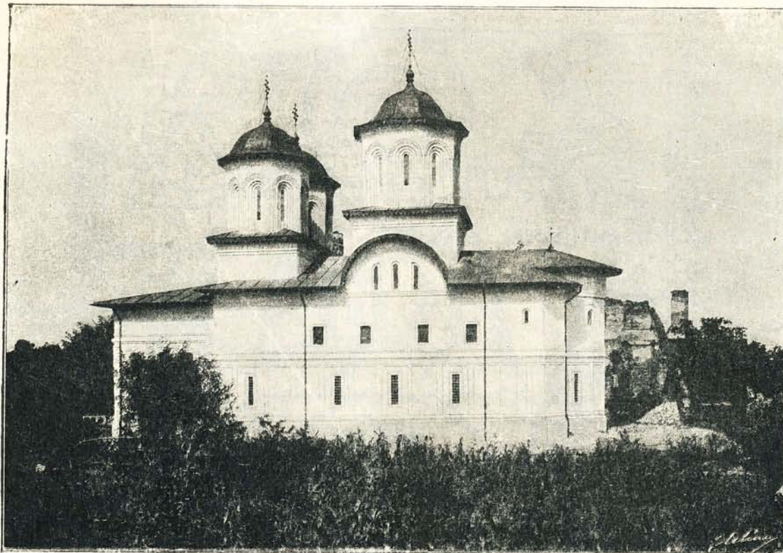
232. Biserica Domnească a Palatului din Târgoviște, după restaurare (C M I, II, 183). Zidită de Matei Basarab lângă palatul domnesc, care fusese reconstruit tot de el (fig. 239) îi plăcea să stea mai mult la Târgoviște, întocmai ca domnii glorioși din sec. 15.
