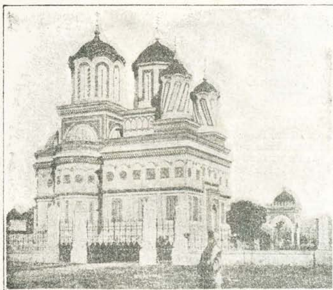
177. Mănăstirea Curtea de Argeș, cum se vede azi, restaurată de regele Carol I. (Xen. IV).
