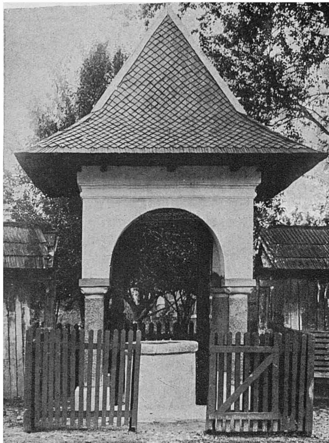
FĂNTÂNA „ING. IOAN SĂBĂ- REANU” construită în anul 1937. S’au construit 6 fântâni în acest stil, între cari 3 în anul 1938.
