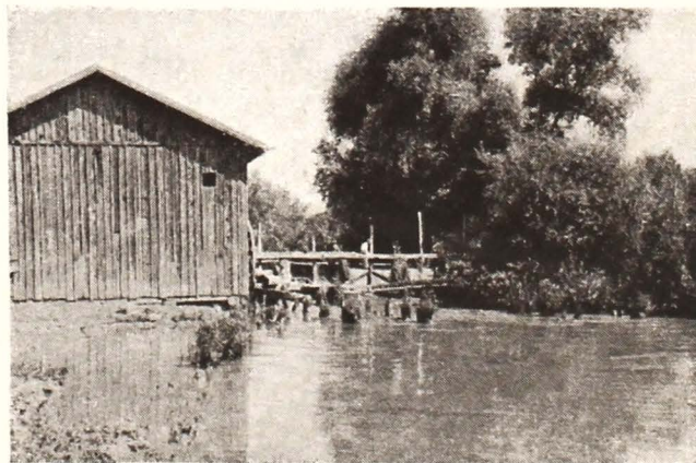
Fig. 41. — Morile pe Dâmbovița creiază remuuri dezastroase pentru sănătatea publică și canalizarea Capitalei.
