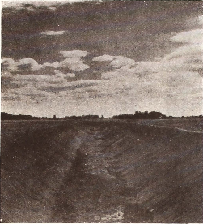
Fig 11. — O secțiune a canalului de aducțiune a apei din Ialomița în Colentina.
