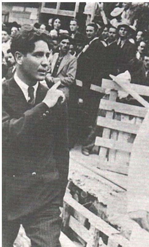
Codreanu inspectând un șantier legionar
