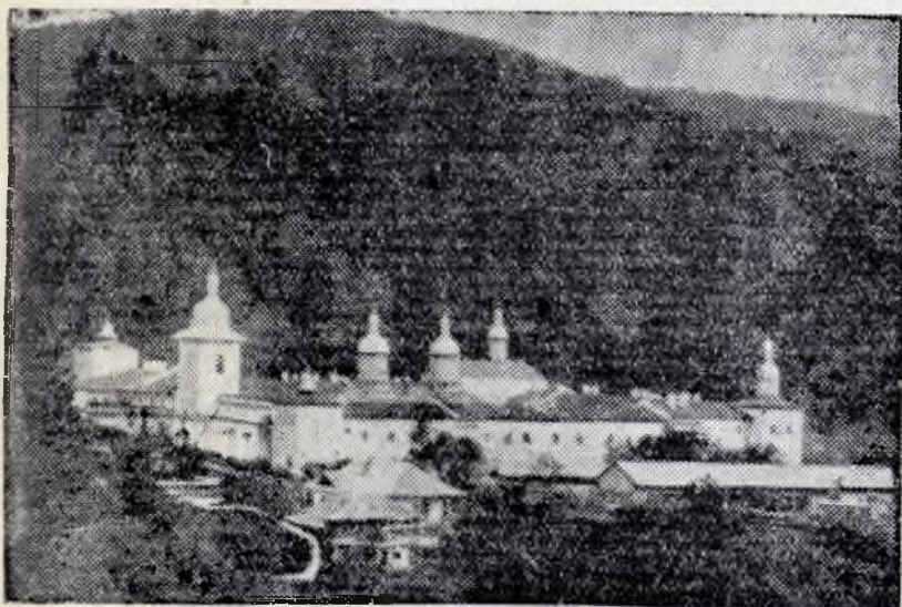
Secu : vedere generală.
