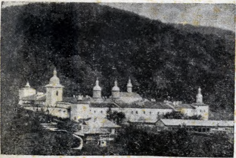
Secu : vedere generală.
