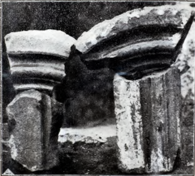
Fig. 11. -- Resturi din ușorii unei uși, din piatră sculptată cu două muluri, două caneluri și două listeluri.
