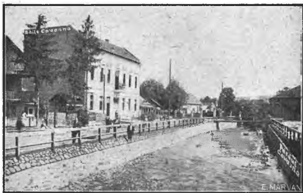
Pârăul Covasna după canalizare. (În față, Casa Vajna Andras)
