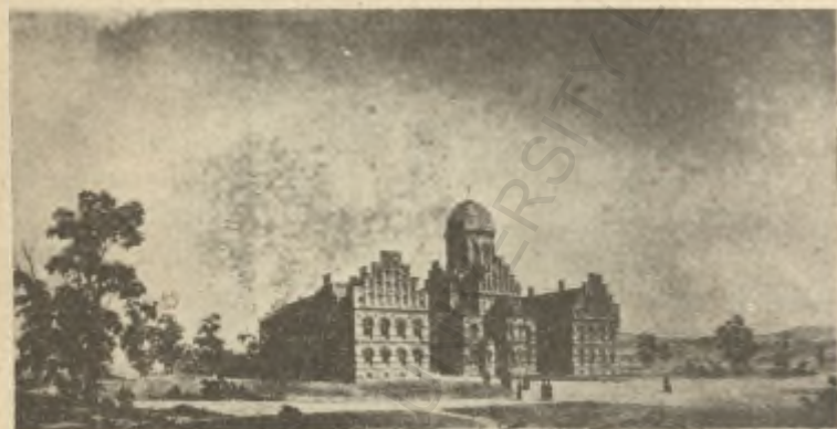
Seminarul teologic cu Biserica Seminarială în planul original, desemnat de arhitectul Iosif Hlavka.
