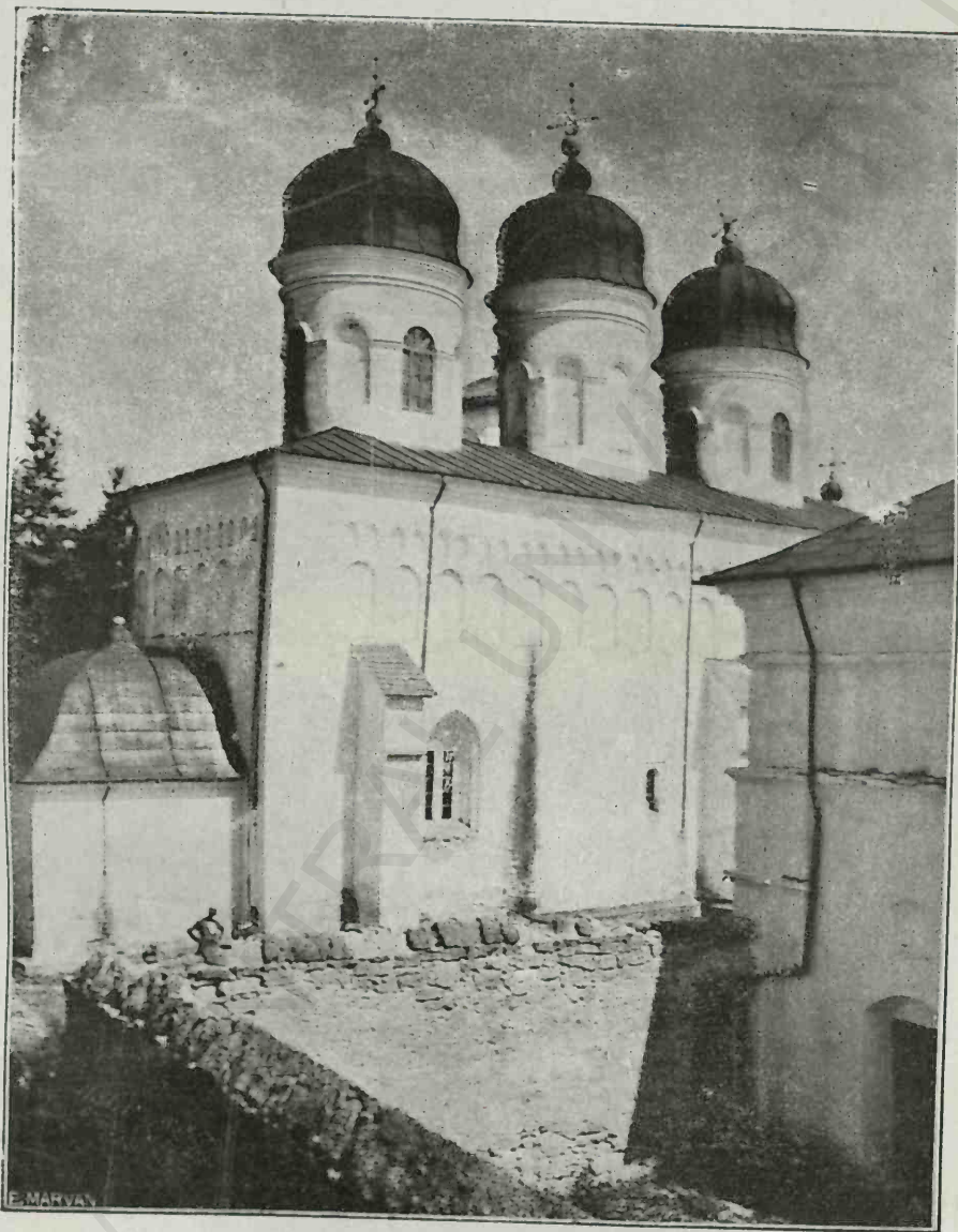
Fig. 172. Dobrovăț, Vedere din spre Sud-Vest
