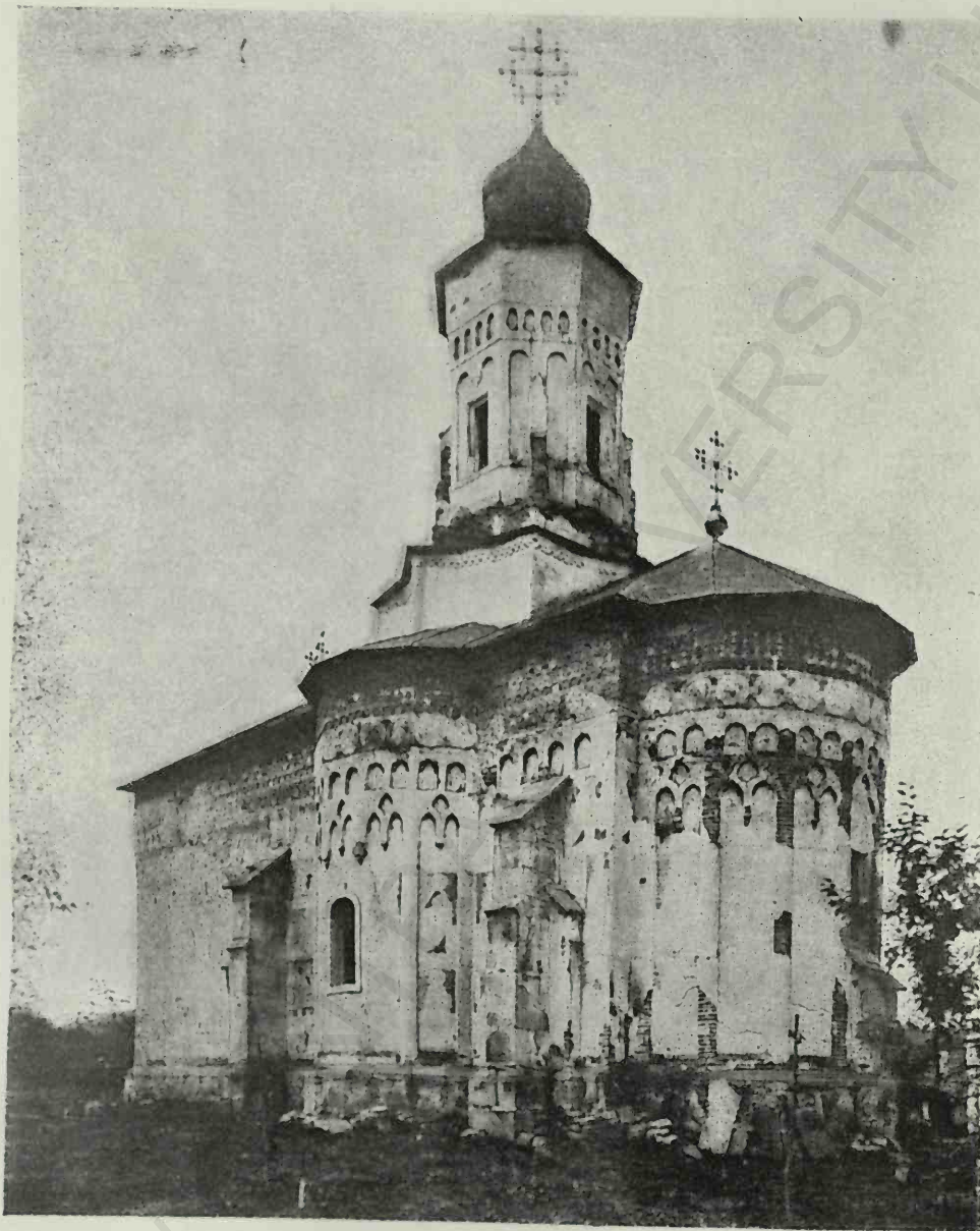
Fig. 62. Sf. Gheorghe, Hârlău, înainte de restaurare
