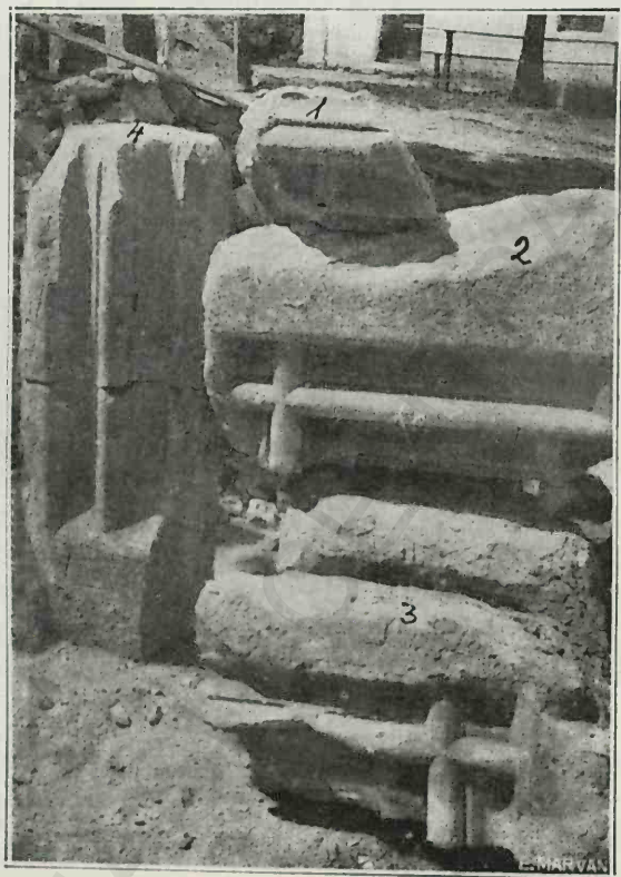
Fig. 84. Sf. Ioan din Vaslui Chenare de ferestre
