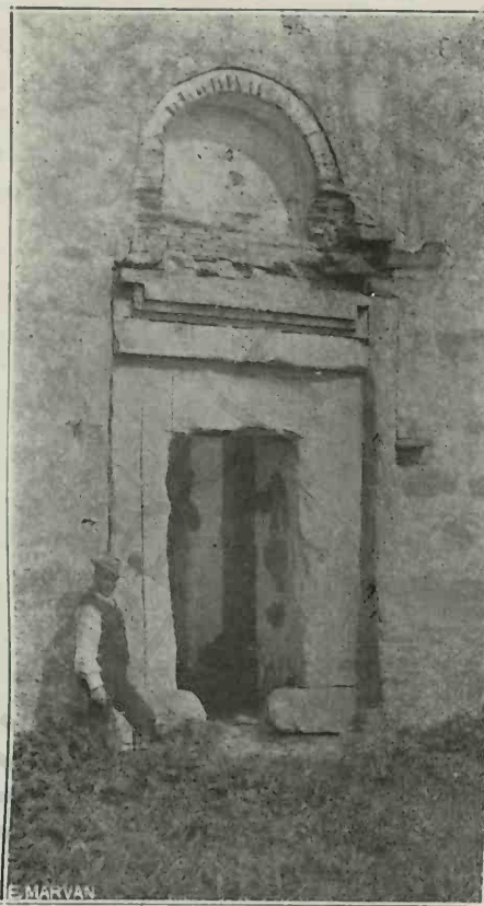
Fig. 14. Baia. — Biserica Albă Ușa exterioară înainte de restaurare (după Bal. Com. Mon. Ist.)
