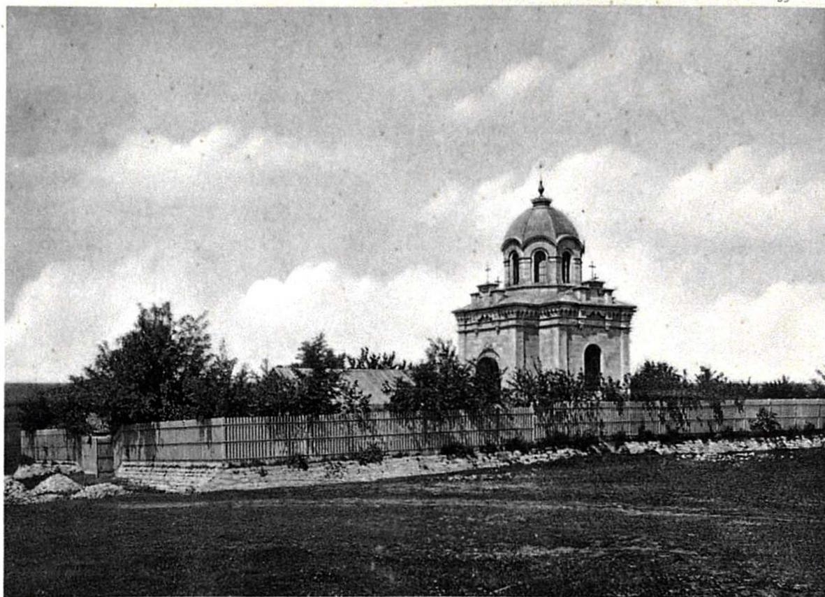
VEDEREA GENERALĂ A CAPELEI GRIVIȚA DIN BULGARIA
