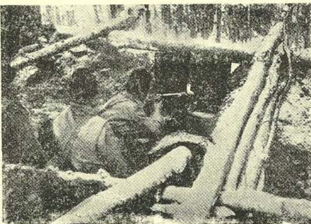
ADĂPOST DE MITRALIERĂ
