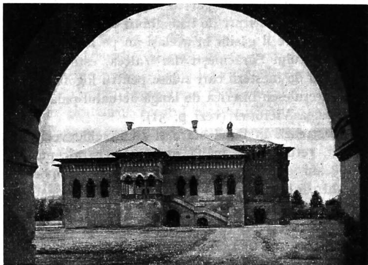
Fig. 130. — Palatul dela Mogoșoaia. Fațada dinspre Răsărit.
