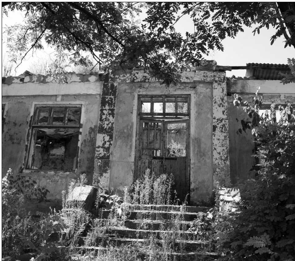
Clădirea școlii construite de români la Frumușica Veche
