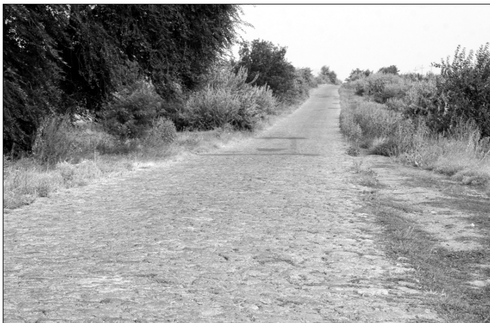
Șoseaua „de pe vremea românilor“ spre Frecăței
