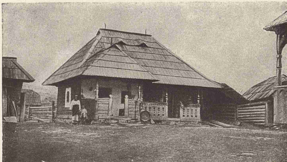
CASĂ ȚĂRĂNEASCĂ (BUCOVINA) PEASANT'S HOUSE (BUCOVINA) MAISON DE PAYSANS (BUCOVINE)
