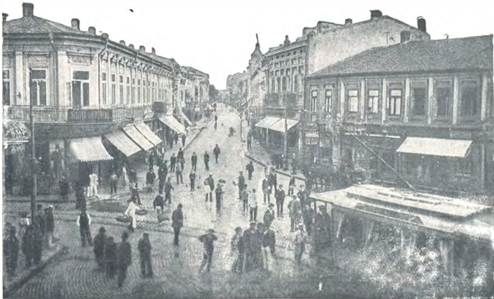
Str. Domnească. — Landescherren Strasse. — Rue Domneasca
