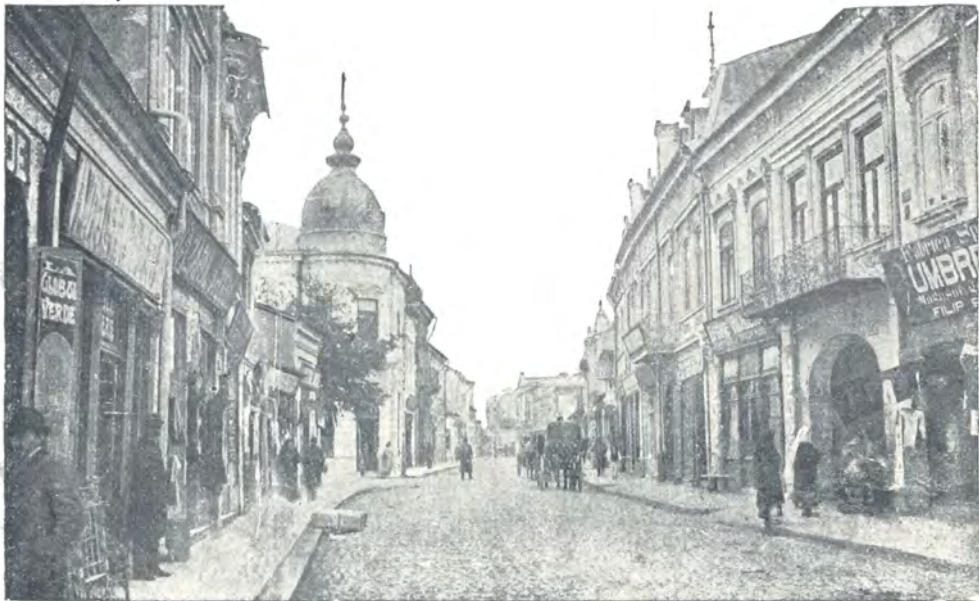
Străzile la Șerban Vodă. — Șerban Vodă strasse. — Rue Șerban-Voda.
