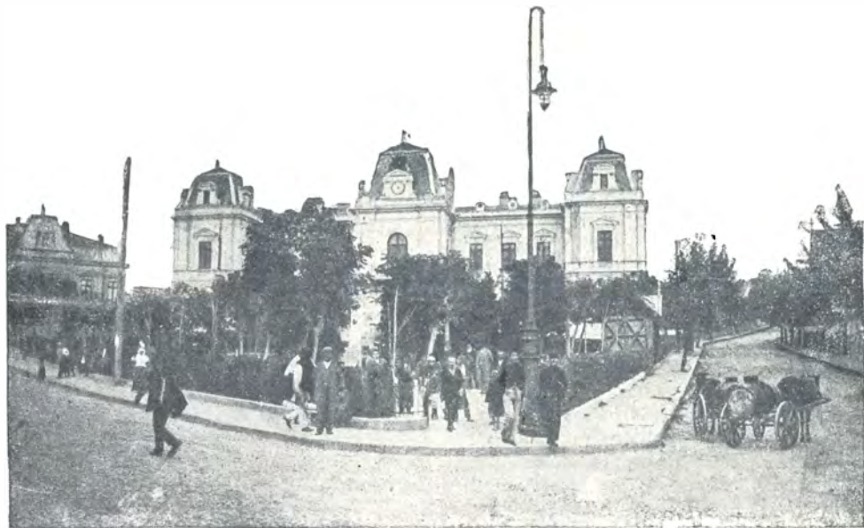
Palatul Administrativ. — Verwaltungspalast. — Préfecture.
