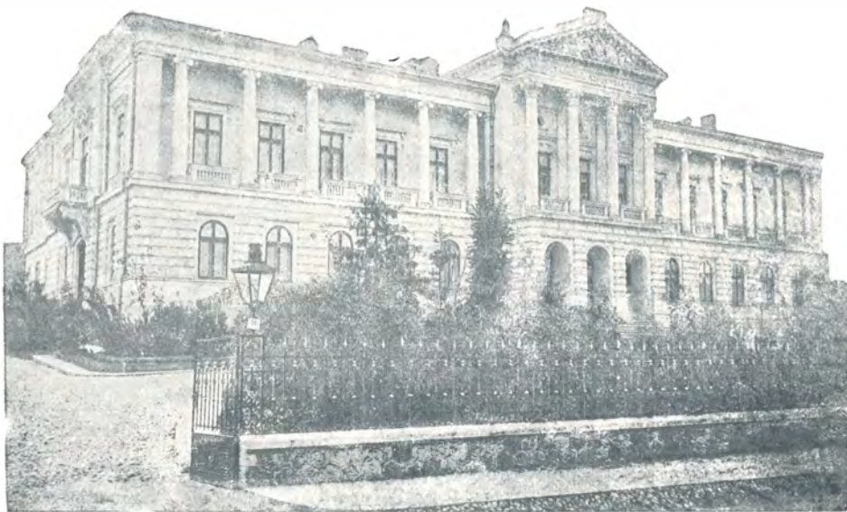
Palatul Administrativ. — Verwaltungspalast. — Préfecture.
