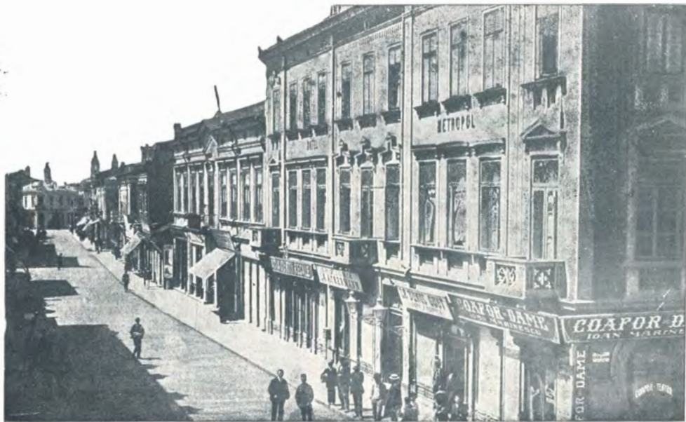
Str. Domnească, Hotel Metropoli. — Lanĉe-terren Strasse. — Rue Domneasca.
