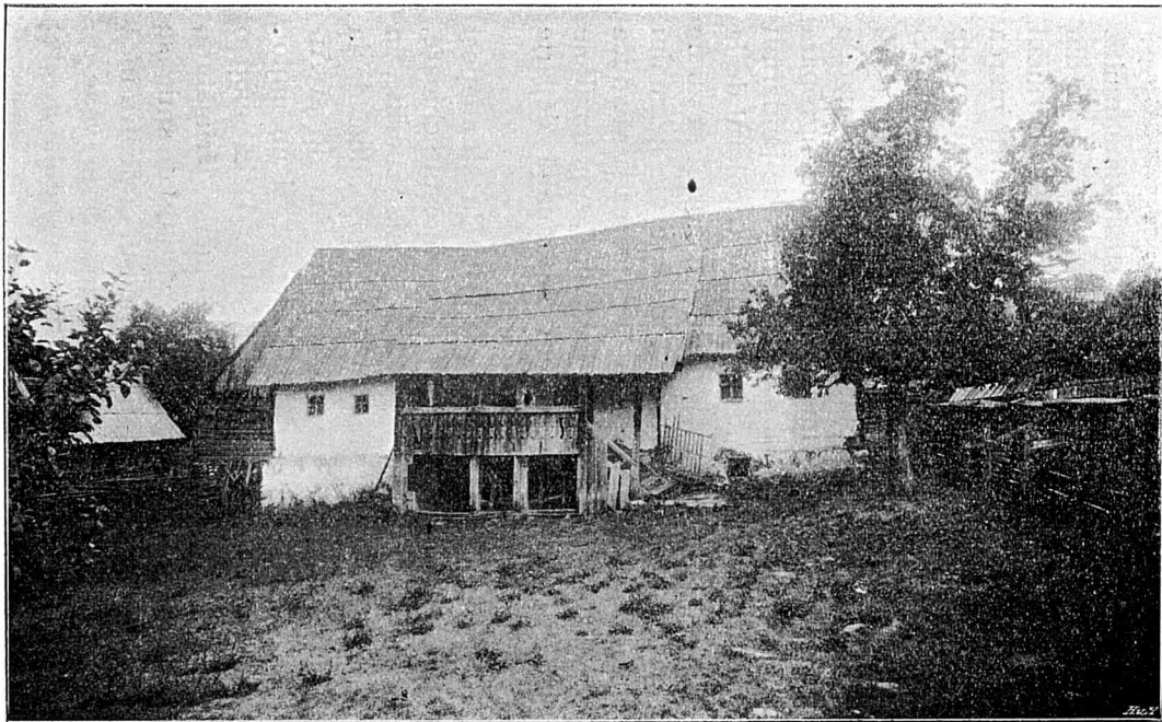
Casa Vlădicilor, în Rășinari. www.dacoromanica.ro
