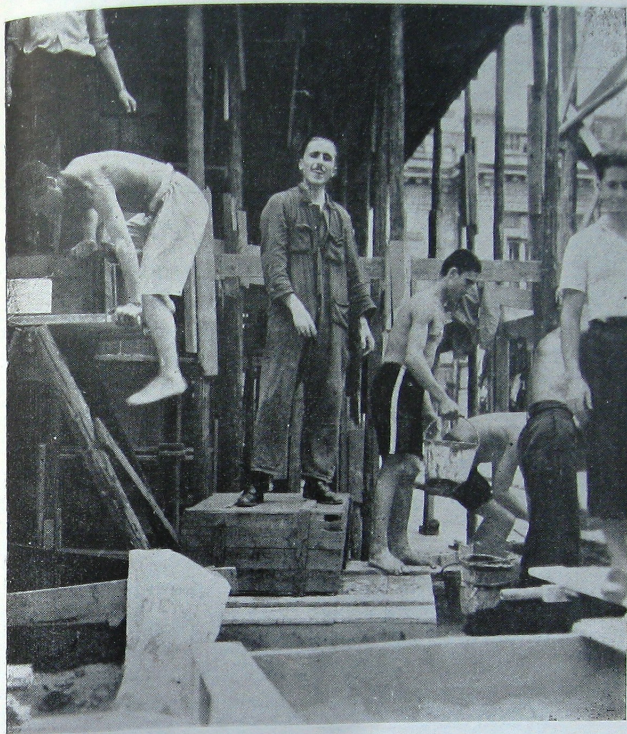
Autorul pe Șantierul din Str. Gutenberg.
