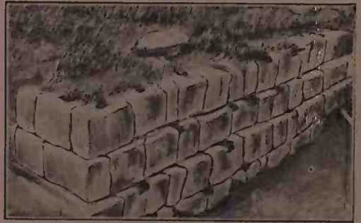
Fig. 10. Temelia unui contrafort din cetatea Dacilor de la Costești. (d. I. Nestor).
