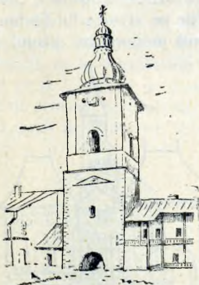
Fig. 11. — Turnul dela M-rea Neamț.
