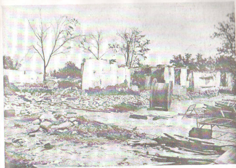
Depozitul telefoanelor din Ismail, cu materialul de construcție, distrus complet.
