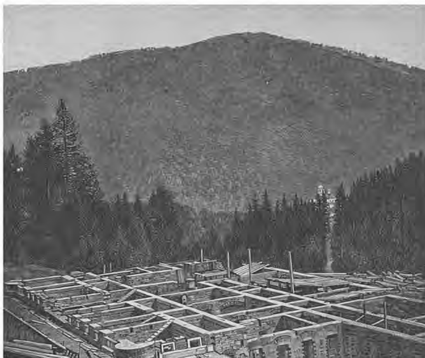
Le château dans ses fondations.
