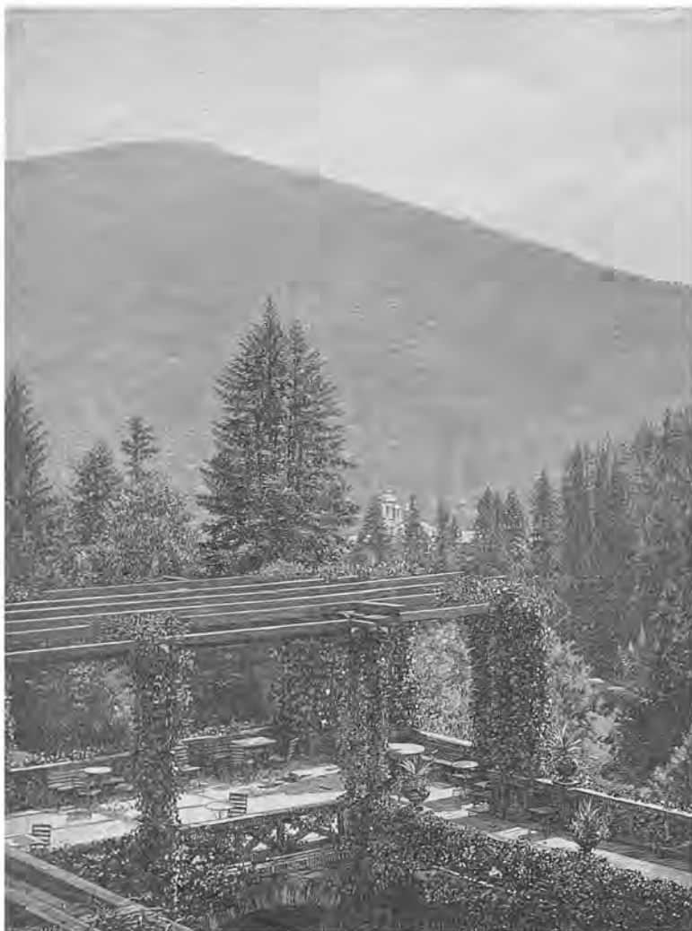
Terrasse au-dessus du portique sud-est.
