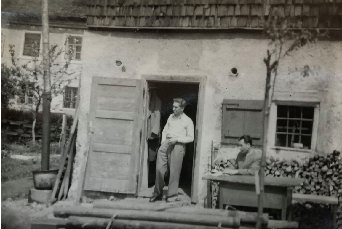
Ignaz Harrerstrasse 75, Salzburg, Austria, 1951: sediul clandestin al Mișcării.
