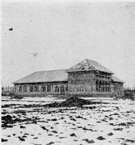
Centrul administrativ Chețani în construcție
