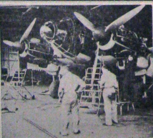
In uzinele Heinkel se increște intens sporid în fiecare zi numărul avioanelor de bombardament. Înălță o serie de aparate grele și cărora motor e pus la punct. Le mai lipsește capota pentru ca să fie gata să-și ia zborul.
