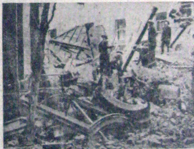
Bombardamentul sursilor de centru industrial englez Sheffield, a fost de proporții extraordinare, așa cum reținează telegrama. Fotografia noastră înălțează munca pentru „deblucarea străzilor” impropriu circulației.
