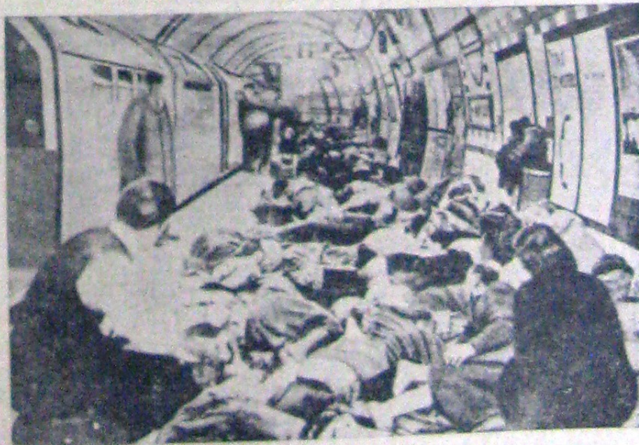
Străduiri în vedea se mai pot edifica în timpul nopții locuitorii Londrei, a rămas subterana metrou-ului. De cum se lasă seara, se dă o adevărată lupă pentru ocuparea unui colț.
